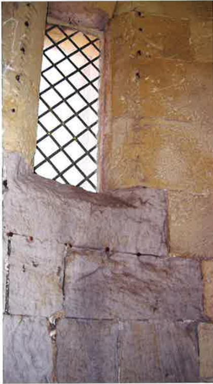
Figuur 20. Torenportaal van de Sint-Quintinuskerk te Hasselt, met asgrijze, licht verzandende restauratiesteen afkomstig uit de groeve van Opgrimbe. (Foto Roland Dreesen)
